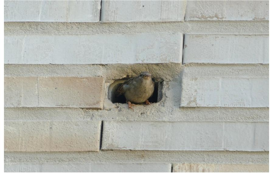
Niststeine können bei der Sanierung oder im Neubau erfolgreich in das Wärmedämmverbundsystem eingesetzt. Foto: Caroline Seige
